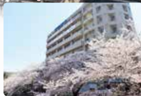
関西福祉科学大学 2号館
