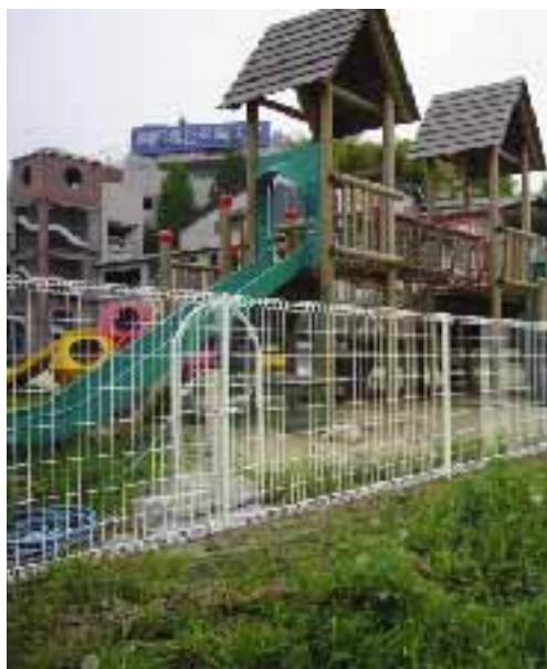
新しく設置したフェンス
