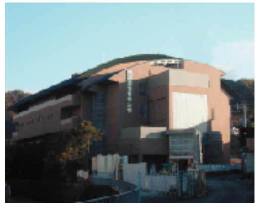
完成間近の学園総合体育館(平成18年12月)
